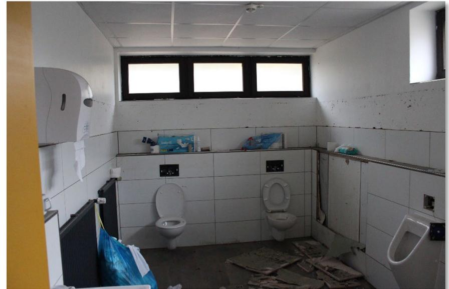
Schäden im Sozialbereich der Feuerwehr mit deutlich sichtbarem Wasserstand der Überflutung
